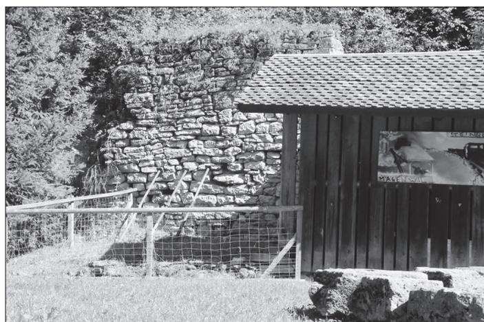
Die Trockenmauer muss gestützt werden, sie ist einsturzgefährdet. Foto: hhs
